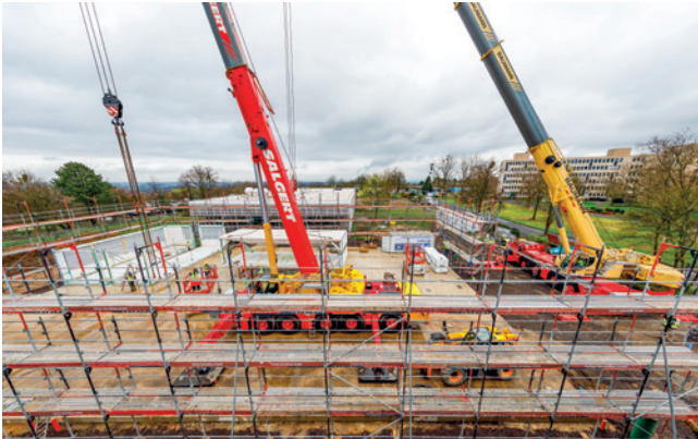
Die Bereitstellung und Instandhaltung von Infrastruktur ist eine Säule des Amtes. Dabei bedient sich das BAIUDBw auch serieller Bauweisen, wie hier der Modulbauweise.
